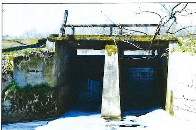
Fot. 2. Jaz szandorowy umożliwiający regulację poziomu wody w zbiorniku Topiło oraz odpływ wody ze zbiornika (fot. A. Stolarek)
