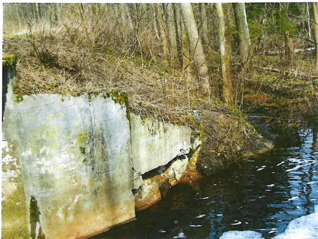
Fot.11. Skorodowany beton na przyczółku jazu dolnego (fot. E. Pierzgalski)
